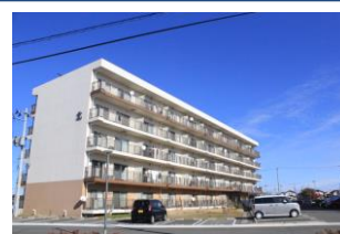
災害公営住宅（多層階タイプ）
