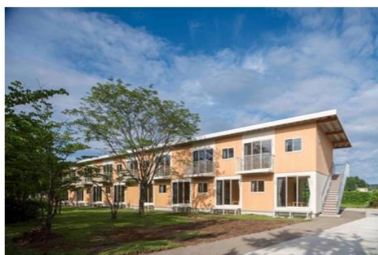
2024 DLT 恒久仮設木造住宅（珠洲市）
