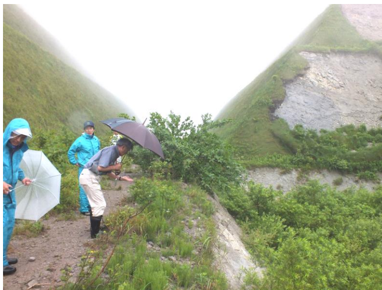
加美町・田代岳の調査。崩れやすい岩質の水源地で、地滑りだらけ、処分場には不適だ。樹木が枯れる強風地帯で、この日も強い風が。ここに焼却炉を設置する計画も、疑問だ（7月4日）
