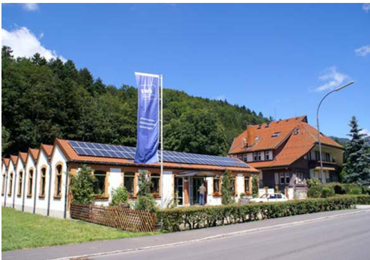
写真4-4 EWS 本社社屋 （出典）写真4-1に同じ
